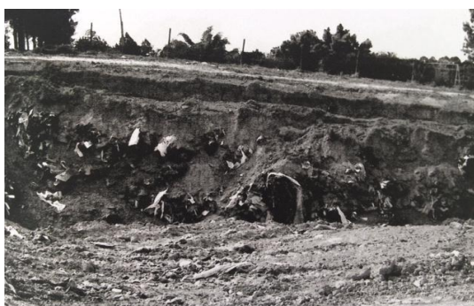
Figura 3. Foto evidenciando rejeitos sólidos industriais com camada de terra insuficiente para completa cobertura, deixando-os a céu-aberto.
