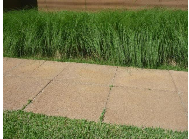
Figura 21 – Piso de concreto permeável
