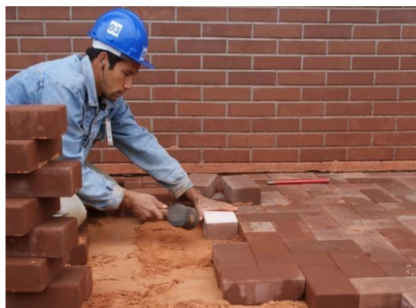
Figura 2: Pisos de tijolo de solo-cimento. Fonte: http://ecomaquinas.com.br/noticias/188
