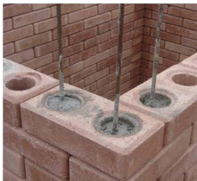
Figura 8: Colunas em alvenarias de tijolo de solo-cimento.
