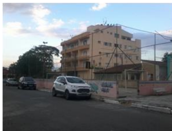
Figura 2 – Foto da quadra danificada e rampa de acesso a cadeirantes esburacada
