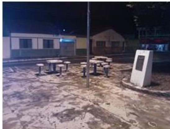
Figura 6 – Foto das mesas e bancos de cimento mal conservados
