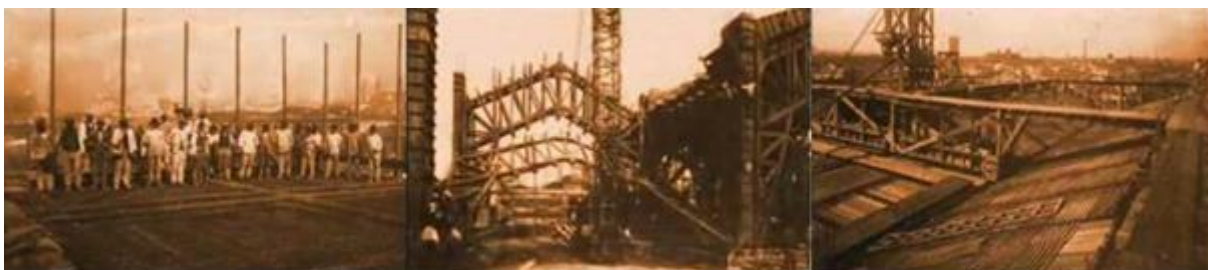
A construção do Mercado Central. Fonte: < https://www.youtube.com/watch?v=GSxvXMtJ9Q8 >
