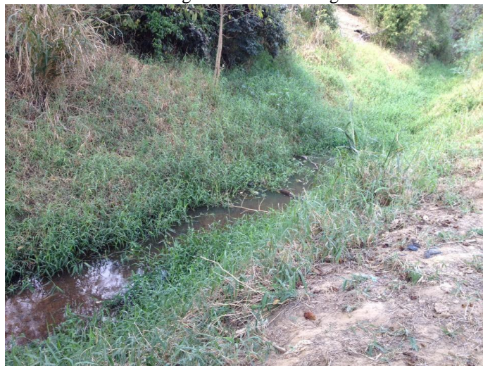
Figura 4 – Trecho do Rio Coatinga nos fundos de órgão de Saúde Público da Região
