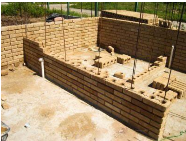
Figura 3: Alvenaria de tijolo de solo-cimento. Fonte: http://www.monteseuprojeto.com.br
