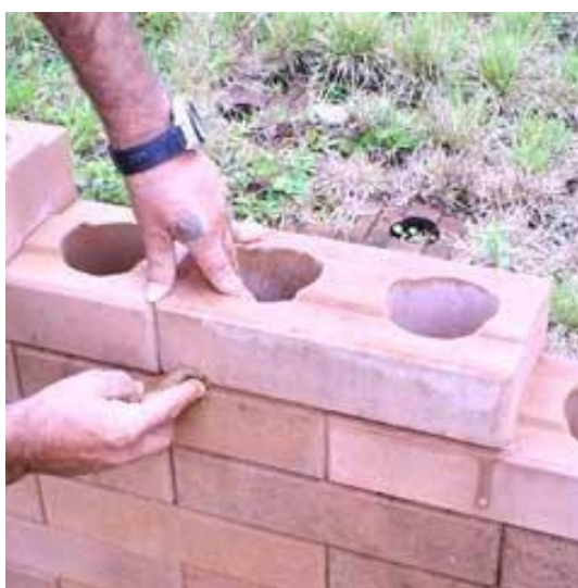
Figura 5: Câmaras de ar formadas dentro dos tijolos. Fonte: http://site.noticiaproibida.org/ideias-sustentaveis.html
