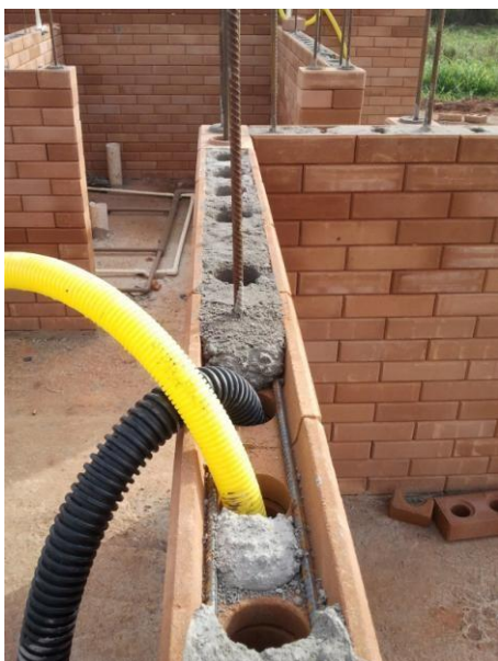
Figura 7: Instalações elétricas em alvenaria de tijolo de solo-cimento.
