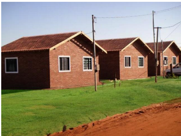
Figura 10: Construção de casas populares utilizando o tijolo de solo-cimento.
